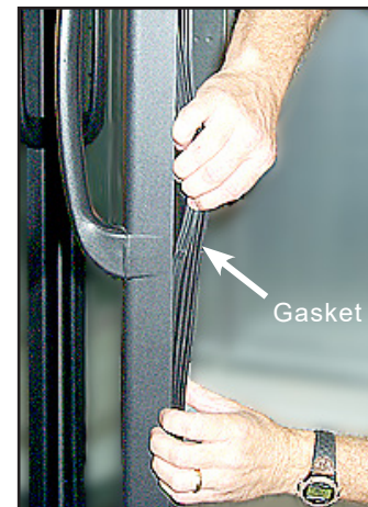
Remove Door Gasket
